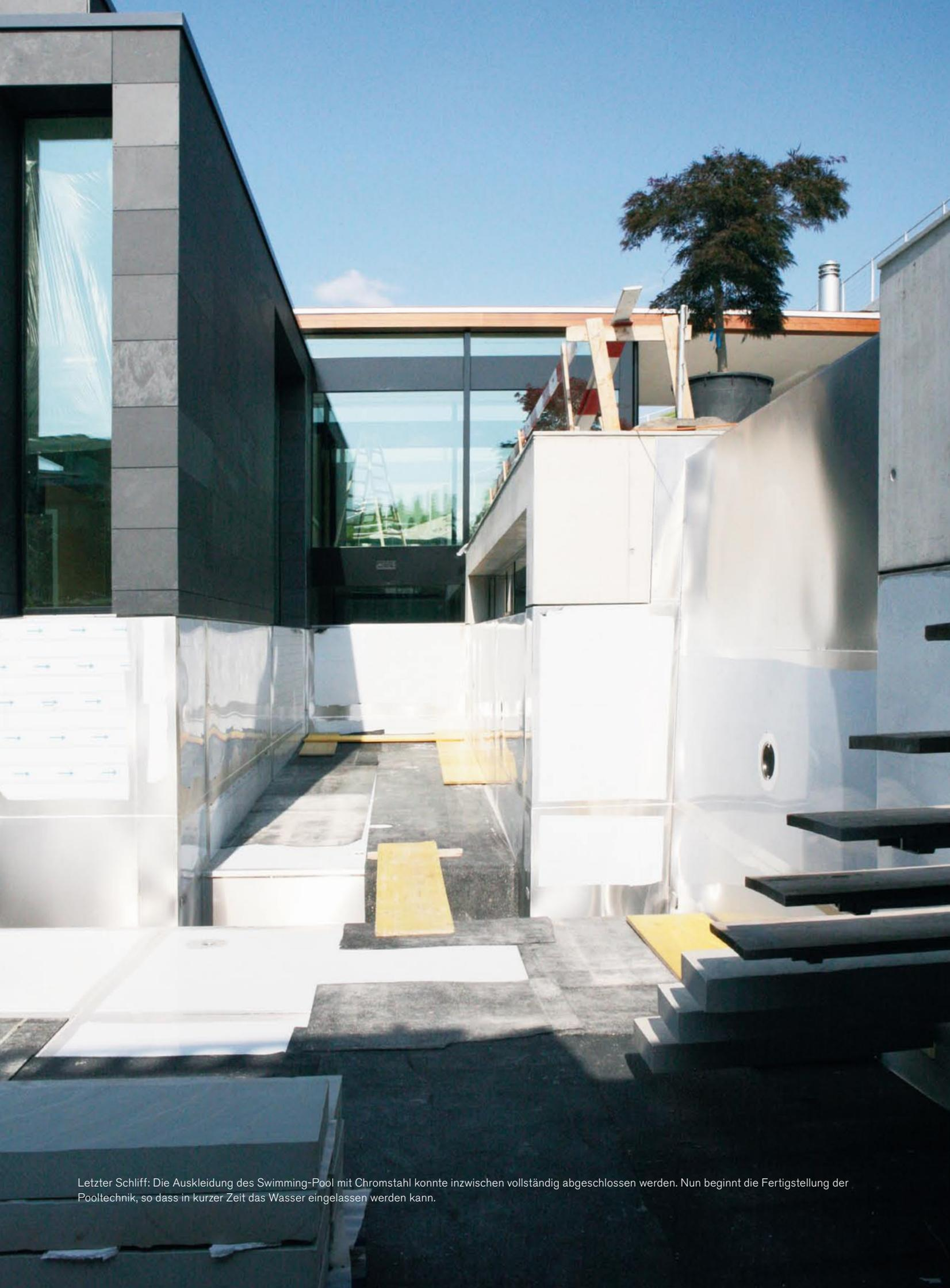
Letzter Schliff: Die Auskleidung des Swimming-Pool mit Chromstahl konnte inzwischen vollständig abgeschlossen werden. Nun beginnt die Fertigstellung der Pooltechnik, so dass in kurzer Zeit das Wasser eingelassen werden kann.
