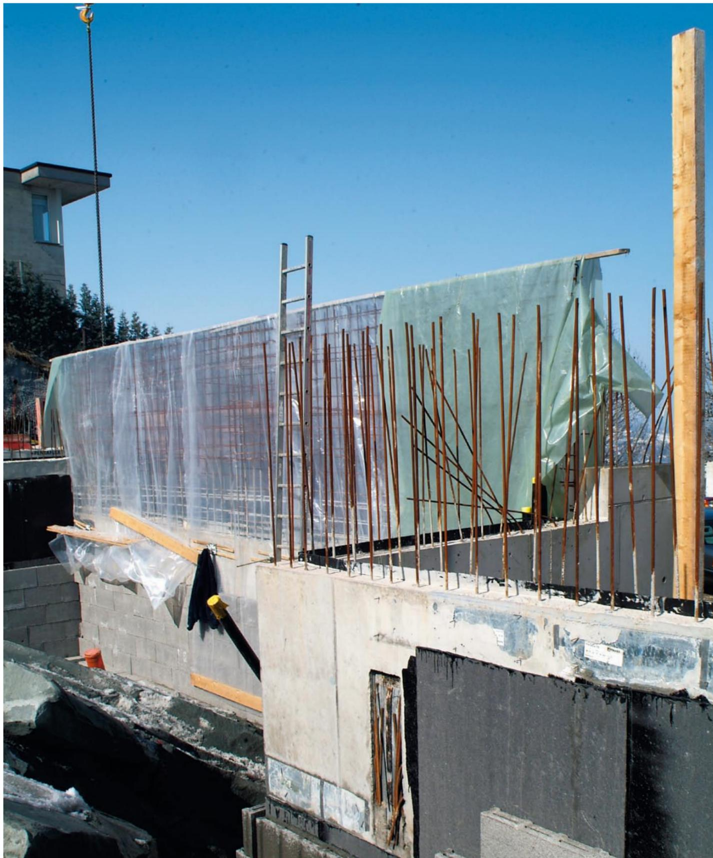
An dieser Kelleraußenwand ist gut zu sehen, was alles nötig ist, damit später keine Feuchtigkeit ins Hausinnere dringen kann. So werden die Aussenwände mit Bitumen-Dichtungsbahnen versehen und mit Filterplatten bestückt, die das Wasser in den Hohlräumen kontrolliert zur Sickerleitung abfließen lassen.
