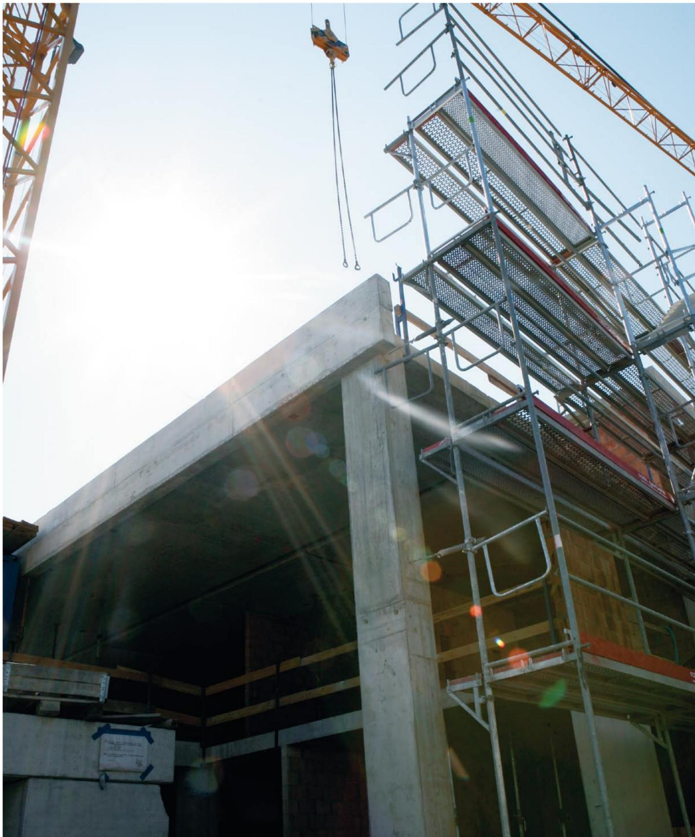
Hier sieht man gut, wie inzwischen auch das Mittelgeschoss hochgezogen werden konnte. Nun folgt etappenweise die Gerüstung, auf dass dann auch die Decken und Wände des Attikageschosses gemauert respektive betoniert werden können.
