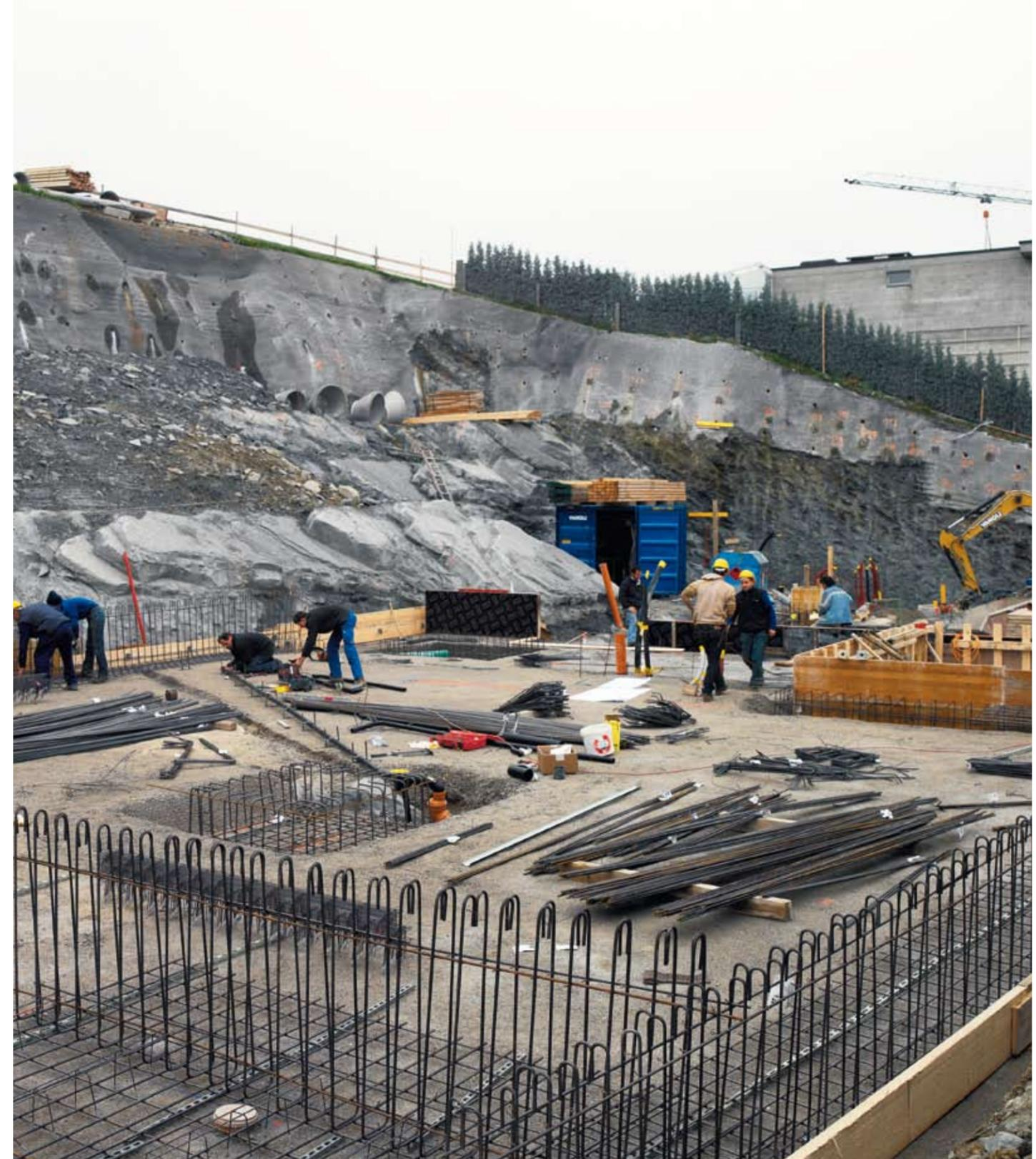
Auf diesen Bildern schreiten die Aushubarbeiten zügig voran. Wichtig ist in dieser Phase, dass die Baugrube vollständig gesichert wird. Dafür werden unter anderem die Böschungen in einem aufwändigen Verfahren fixiert. Erst wenn die Sicherung abgeschlossen ist, kann mit den Bewehrungsarbeiten begonnen werden.
