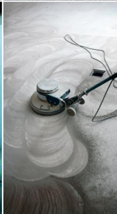
Damit die Übergänge der diversen Böden schwellenlos sind, muss partiell abgeschliffen werden.
