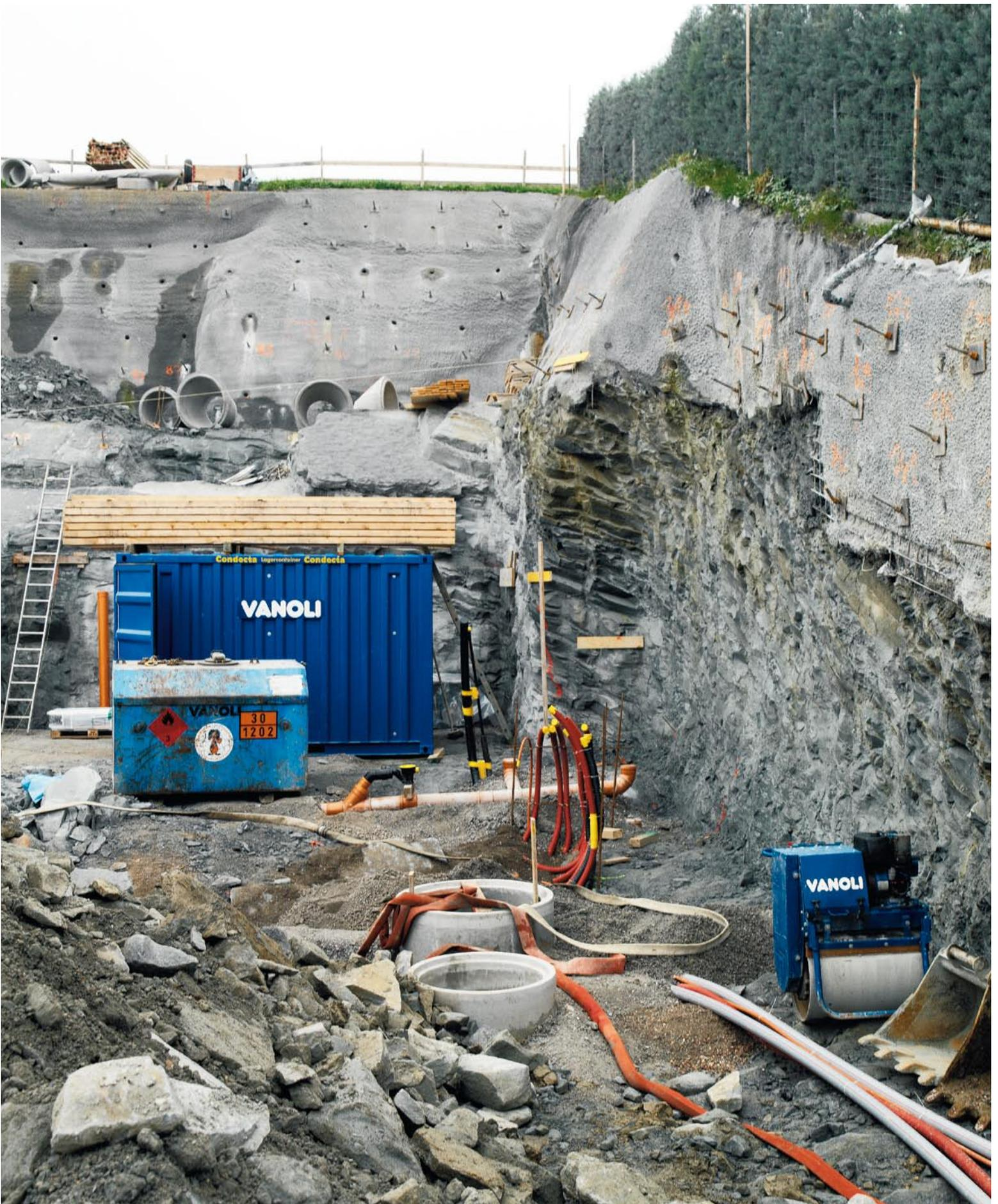
Zwischen dem Haupt- und dem Annexgebäude müssen diverse Erschliessungs-, Kanalisations- und Verbindungsleitungen gelegt werden. Diese werden zentimetgenau unter der Fundamentplatte verlegt. Die Löcher in der Böschungsfixierung sorgen dafür, dass sich dahinter das Wasser nicht aufstauen kann.
