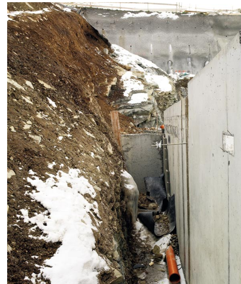
Bild oben: Hier sieht man gut, wie die Decke des Parkgeschosses zunächst mit Holztafeln, die von unten gestützt werden, geschalt werden. Bild unten: An den Aussenwänden des Gebäudes muss nach wie vor noch entwässert werden.
