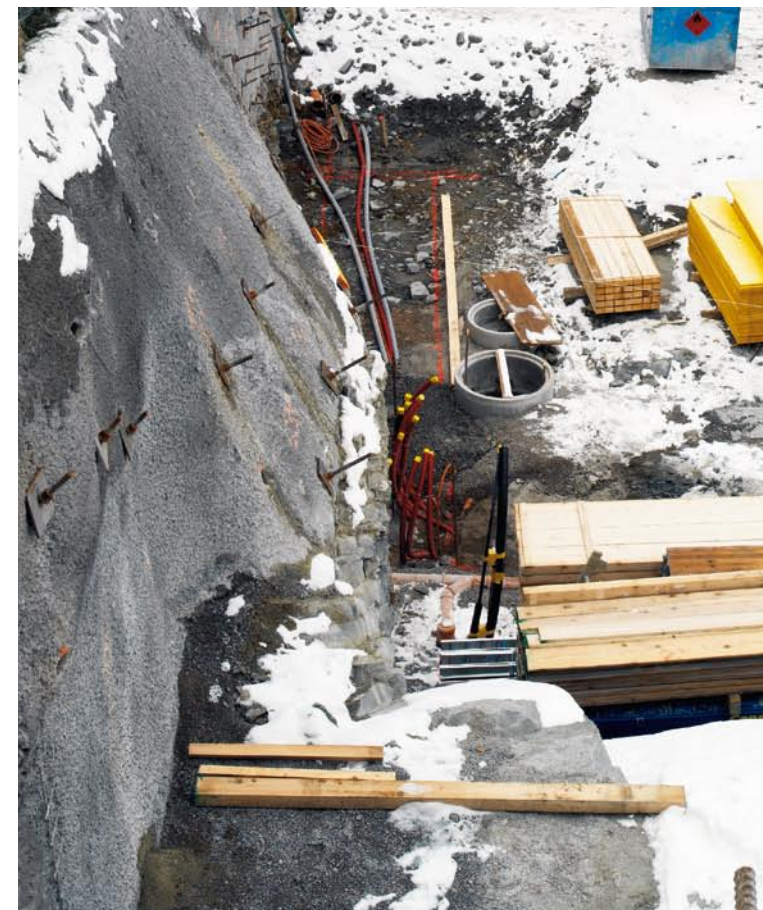
Bild oben: Wenn die Wände bei Kälte betoniert werden müssen, werden sie anschließend warm eingepackt, damit sie nicht zu schnell auskühlen. Bild unten: An dieser Stelle kommt später die Bodenplatte für den Technikraum zu liegen.
