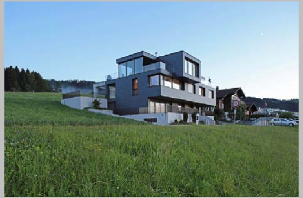
Abb_02: Einfamilienhaus am Zürichsee: Der hoch aufragende Schiefermonolith steht auf einem mächtigen Sichtbetonsockel. Foto: Rathscheck Schiefer
