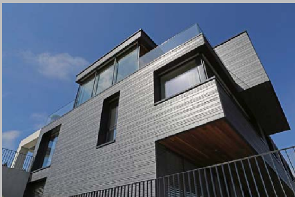
Abb_05: Edel, hochwertig und haltbar: Dynamische Deckung aus Schiefer. Foto: Rathscheck Schiefer
