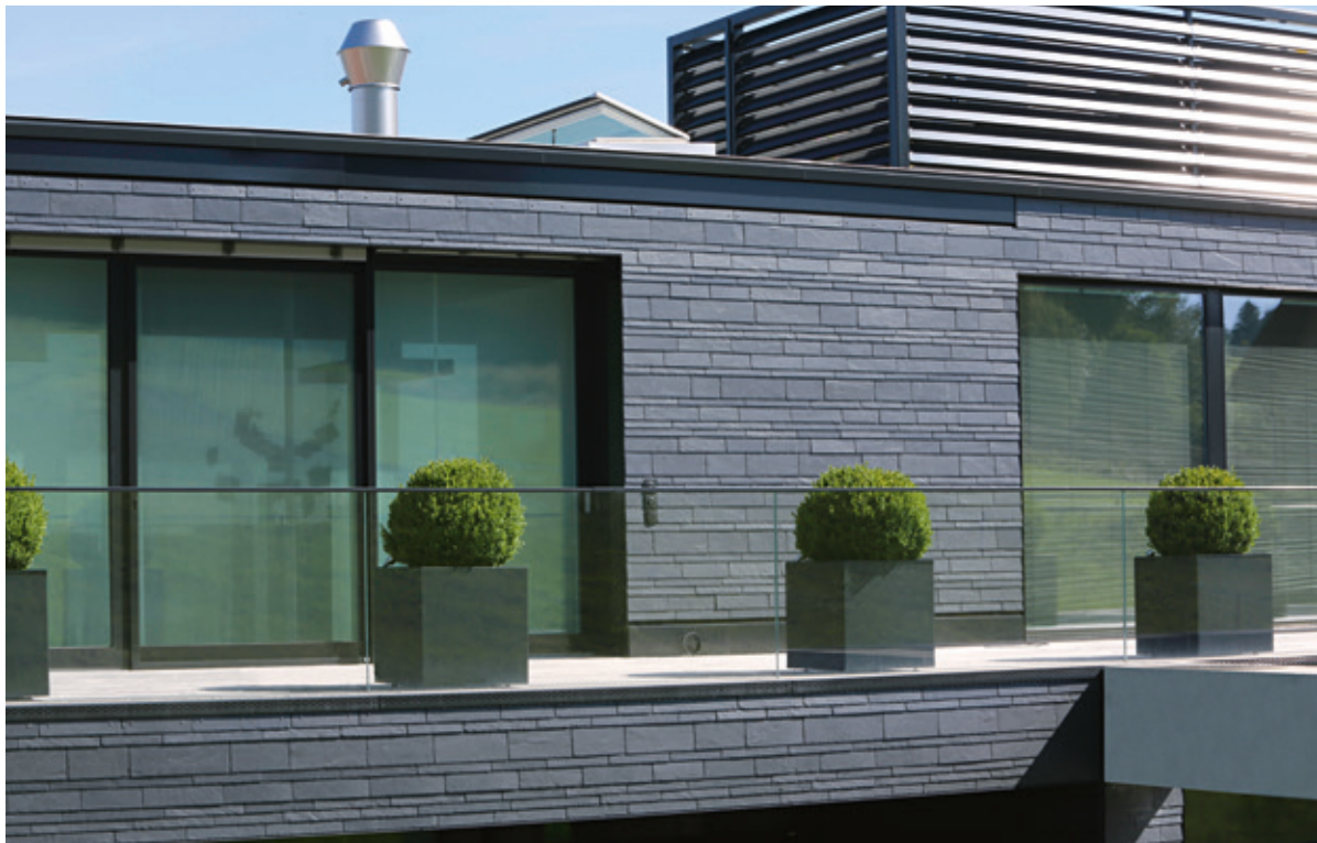
Zurückhaltend dunkel und seidig glänzend präsentiert sich der Schiefer als adäquate Fassadenlösung für witterungsbedingt anspruchsvolle Standorte.
